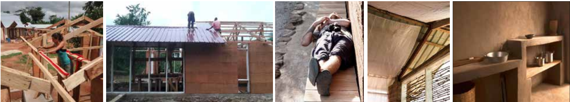
8.-12.. WOCHE - Dach, Innen- und Außenraumgestaltung
