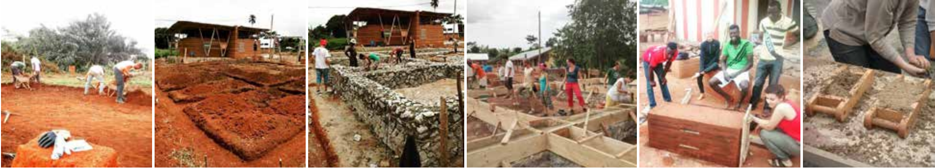
1.- 2. WOCHE - AUSHUB UND BAU EINES LEHMOFENS
